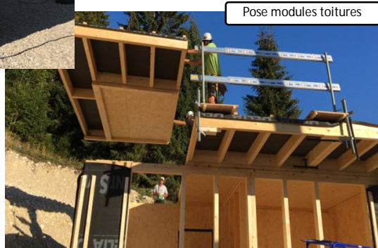
Pose modules toitures
