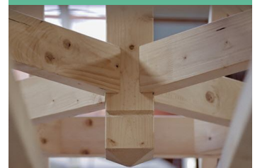
Nœud d'assemblage de charpente
