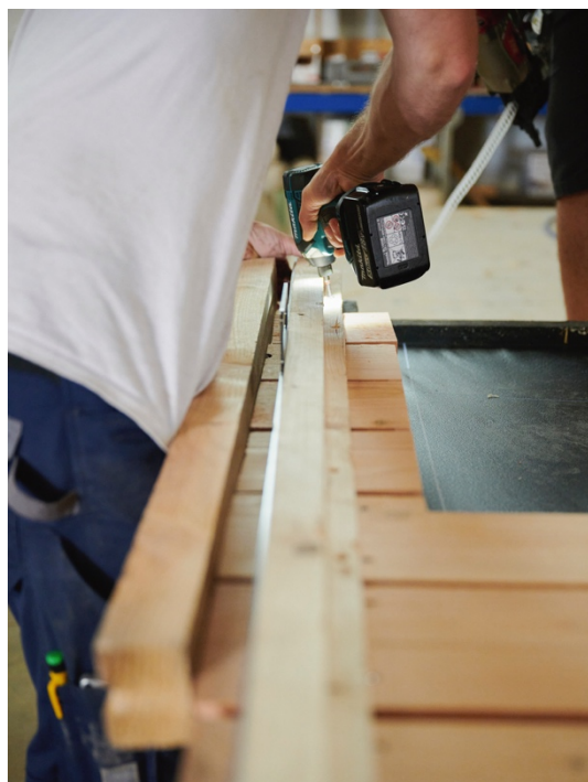
Préfabrication d'une ossature
